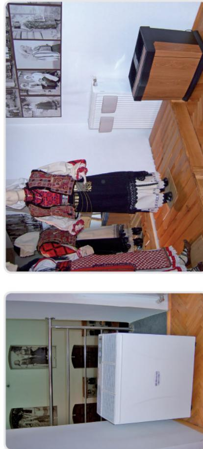
Principiul de funcționare al umidificatoarelor este evaporarea apei reci. Lampa cu ultriolete este un accesoriu care distrug bacteriile ce se pot forma în cuva utilajelor. Umidificatoarele se pot răcorda la sistemul automat de alimentare cu apă, nemaifiind necesare recipientele pentru apă. Un umidificator are capacitatea de a crește umiditatea în aer, dar și de a purifica aerul.
